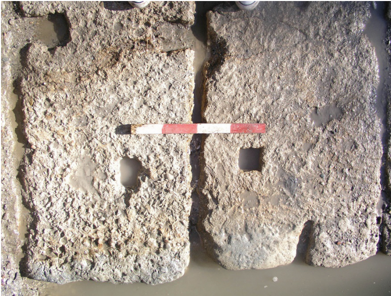
Fig. 21. Détail du radier avec les traces des crampons en plomb-coupe S. 34.
