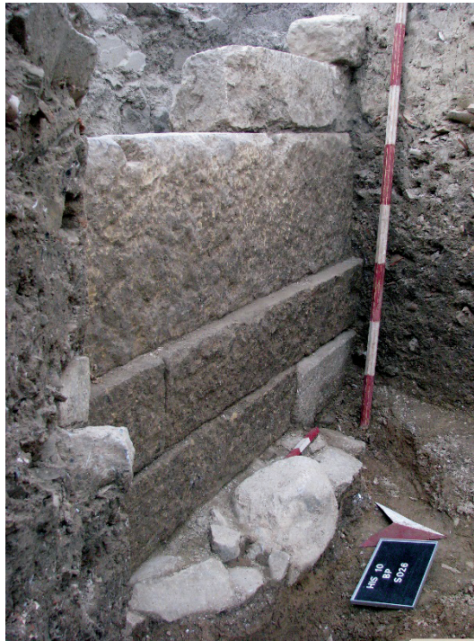
Fig. 24. Le parement intérieur du rempart posé directement sur le rocher-coupe.
