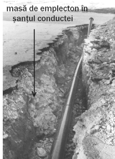
Fig. 22 – Emplectonul zidului spart de șanțul conductei.
