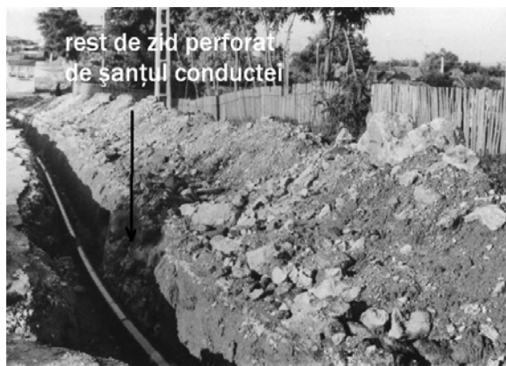
Fig. 21 – Zid spart de șanțul conductei.
