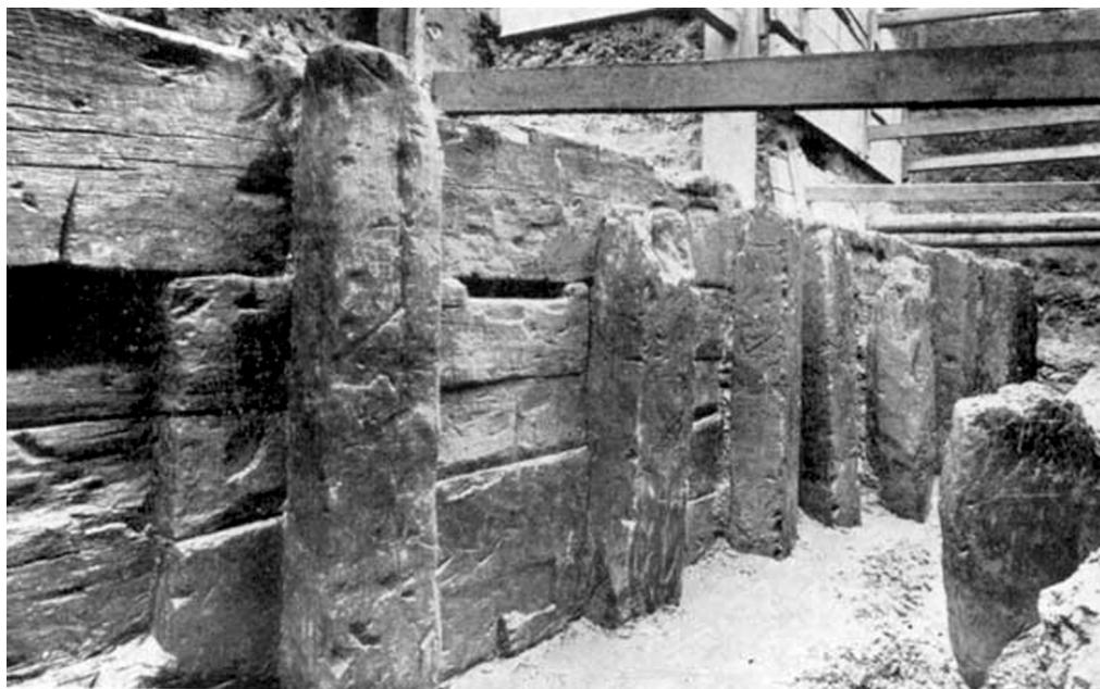
Fig. 10 - Cheul din lemn al instalației portuare de la Colonia Ulpia Traiana (Xanten).
