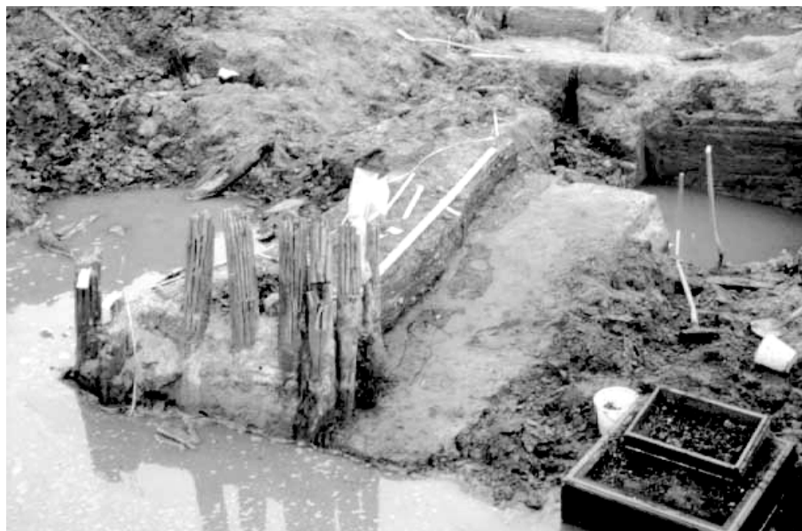
Fig. 3 - Piloni ai instalației portuare de la Velsen I.
