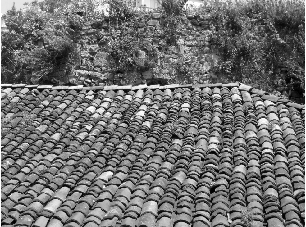
Fig. 1 – Toit d'une maison de Sinope couvert de tuiles fabriquées dans les anciens ateliers de Çobanlar.
