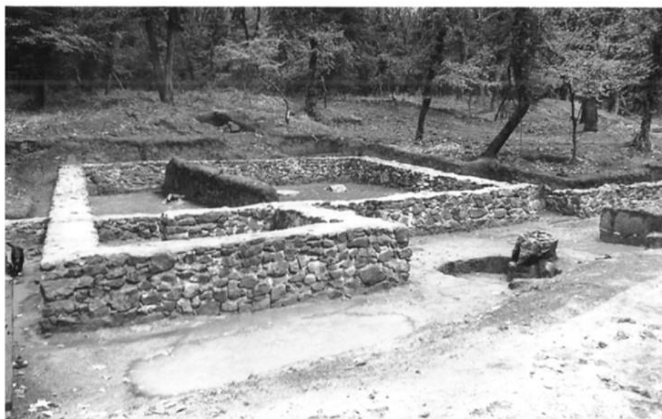
Fig. 21 - c) Telița - Valea Morilor, pavilionul D (foto BAUMANN 1995).
