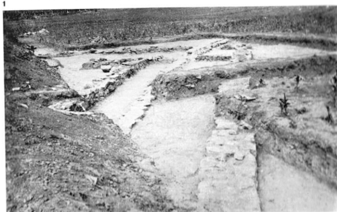
Fig. 16- c) Telița - La Pod. Aspecte de șantier (apud BAUMANN 1980).
