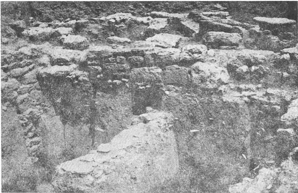
Fig. 6.C 2 interior — faze ale fundațiilor.
