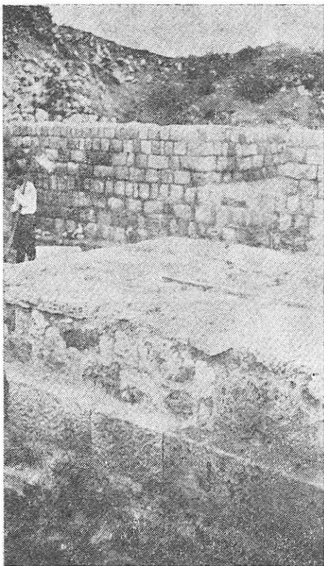
Fig. 2. Turnul 4 — unul din stîlpii centrali (faza I-a) și paramentul laturii de s.v., fiind cu cortina (faza II b).
