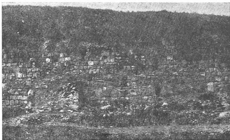
Fig. 5. Curtinele C și D — partea inferioară faza I b, partea superioară faza II b, cu șterpii turaului 3, demantelat, acoperiți de zidărie din faza II b.
