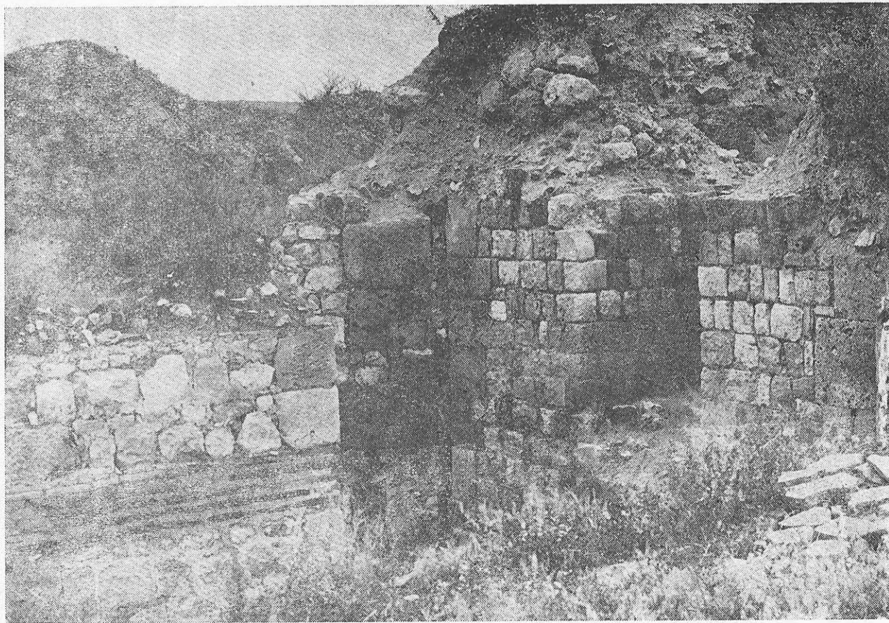
Fig. 8. Turnul 2 — interior, latura s. cu parament vechi din faza II b și latura s. e. cu parament refăcut din faza III b,
