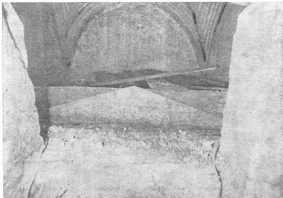
Fig. 6. — Vedere din dreptul intrării asupra interiorului criptei; lada mortuară deranjată de molozul căzut din spărtura făcută de săteni în cupolă.
