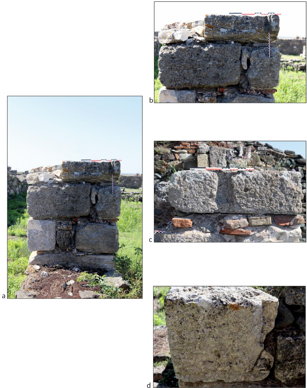
Pl. 10 - Basilique à piliers , E et L – les « caniveaux » : a) Basilique à piliers , E face nord – « caniveau » ; b) Basilique à piliers , E face nord - « caniveau » (détail) ; c) Basilique à piliers , face nord - « caniveau » (détail) ; d) Basilique à piliers , face sud - « caniveau » (détail).
