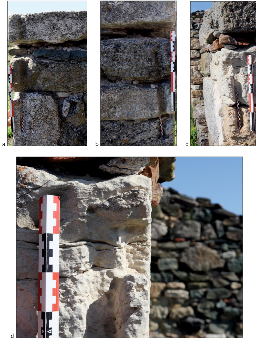
Pl. 8 - Basilique à piliers , pilier A - les caniveaux : a) Basilique à piliers , pilier A, face nord - « caniveau » ouest ; b) Basilique à piliers , pilier A, face nord - « caniveau » est ; c) Basilique à piliers , pilier A, face sud, « caniveau » ouest ; d) Basilique à piliers , pilier A, face sud, « caniveau » ouest (détail).
