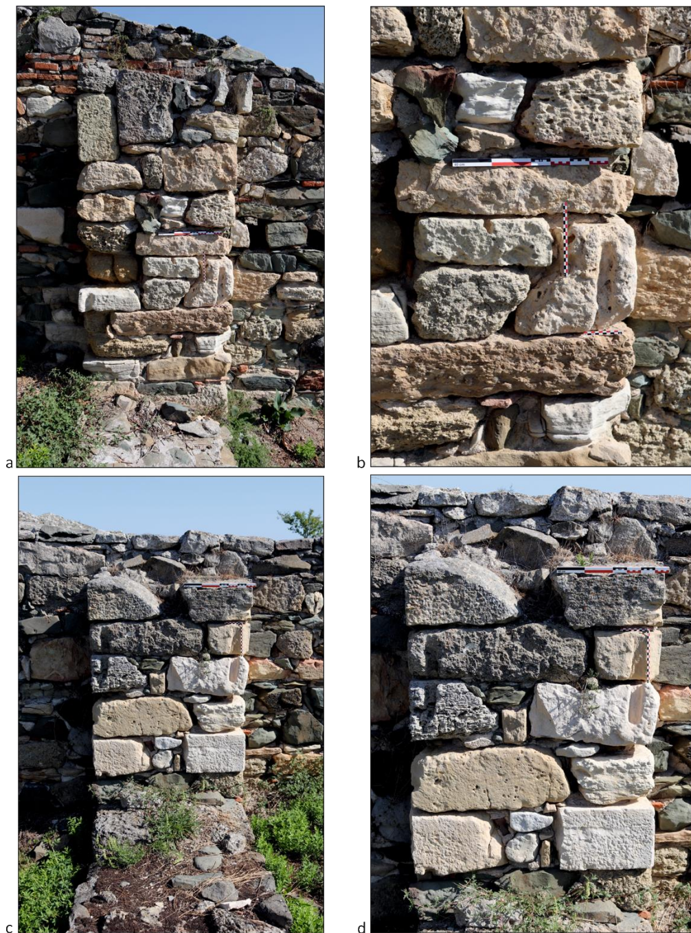
Pl. 9 - Basilique à piliers, B et C – les caniveaux : a) Basilique à piliers, B face sud – « caniveaux » ; b) Basilique à piliers, B face sud - « caniveaux » (détail) ; c) Basilique à piliers, C face sud – « caniveaux » ; d) Basilique à piliers, C face sud - « caniveaux » (détail).
