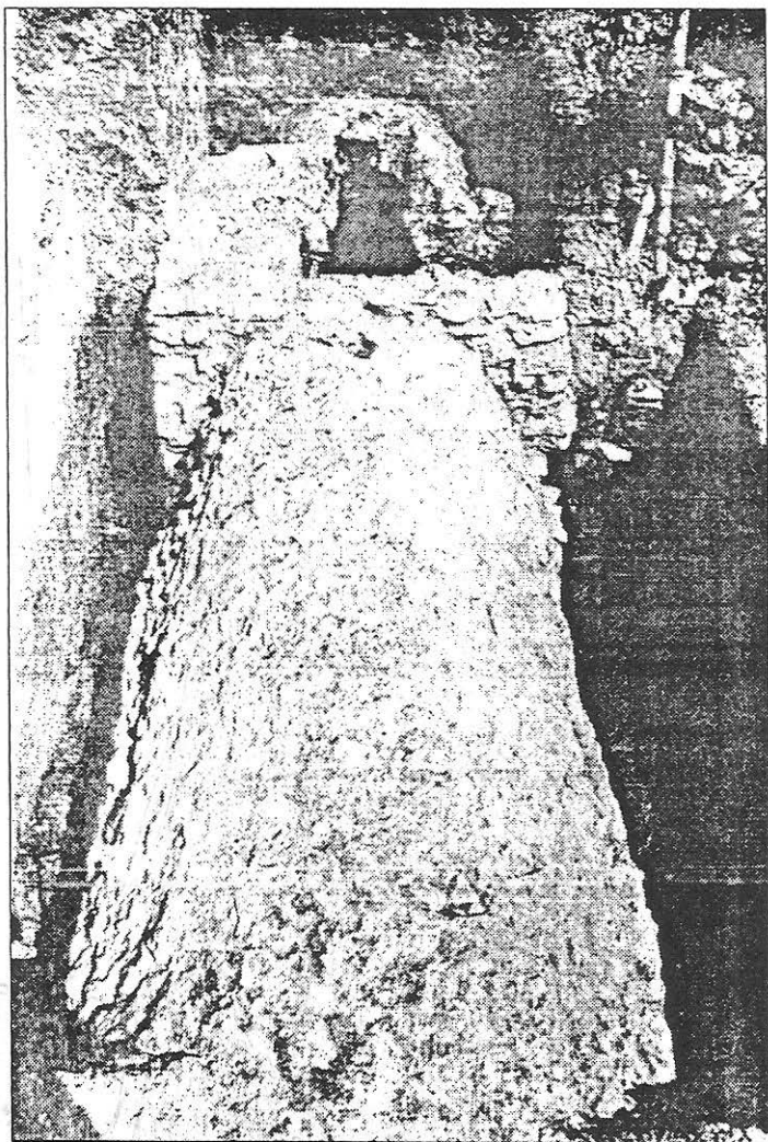
Fig. 9. Ovidiu - apeduct și cămin de vizitare.
