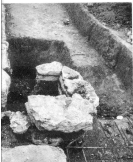
Deversor, str. Teilor nr. 6.
