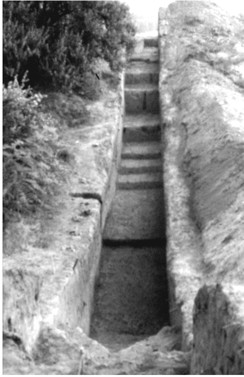
Fig. 10 - Satu Nou – „Valea lui Voicu”. Secțiune prin valul de apărare al platoului de sud; vedere parțială dinspre sud.
